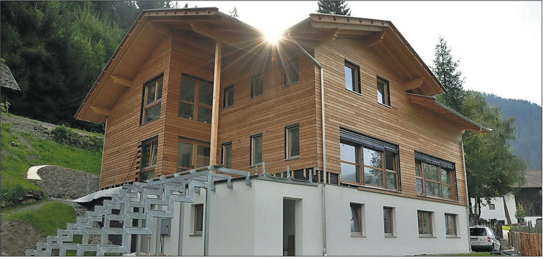
Das Jugendhaus Hahnebaum in Rabenstein steht vor der Fertigstellung.
